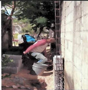
Foto 5: Pegada de block en otra parte del muro.
