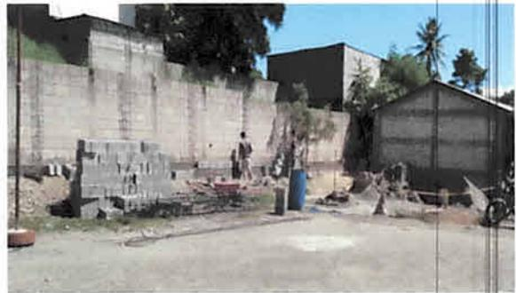
Foto 4: Material utilizado para la construcción del muro
