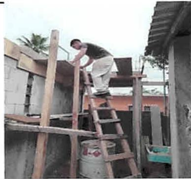
Foto 6: Elaboración de tarima para la fundición del espacio donde va a estar instalado el tanque de agua.
